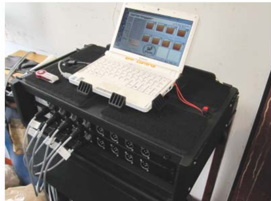
Lastmessungen in Galvanikbädern Laufzeitermittlung BHKW
