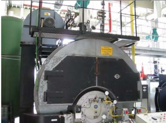
Grundlastmessungen in Großkesselanlagen 10 MW für BHKW Dimensionierung
